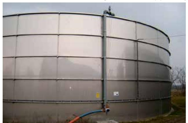
Saug- und Befüllstation über Behälterrand
