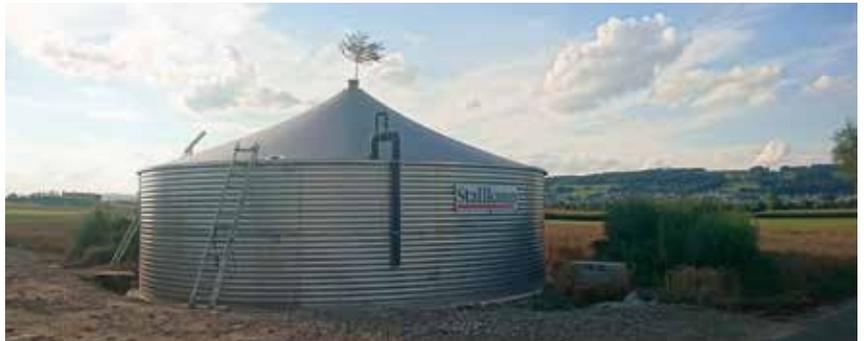
Behälteransicht außen mit Membrandach | Tank view outside with membrane roof
