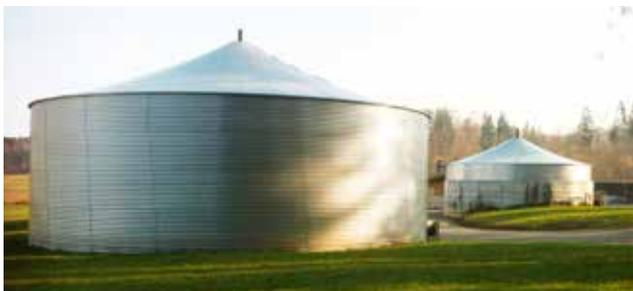
Wellstahlbehälter und aufgestockter Betonbehälter mit Wellstahlbehälter
