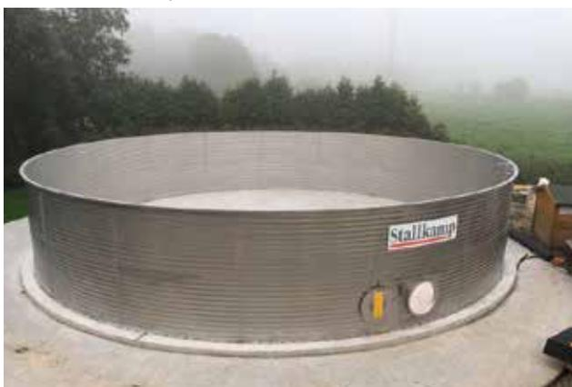
572 m<sup>3</sup> Klärschlamm-speicher aus Wellstahl
