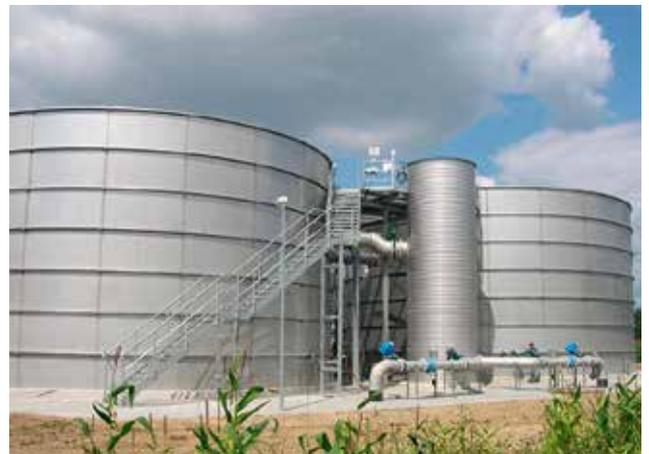
1.664 m<sup>3</sup> Glattstahlbehälter und 51 m<sup>3</sup> Wellstahlbehälter in der Papierindustrie
