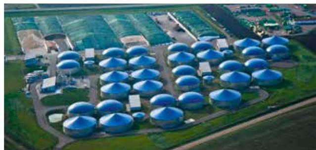
Fermenter, Nachgärer und Gärrestlager einer Biogasanlage
