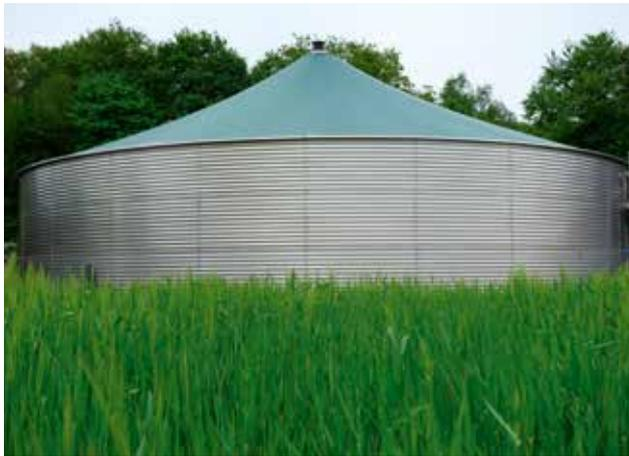
Wellstahlbehälter mit Membrandach
