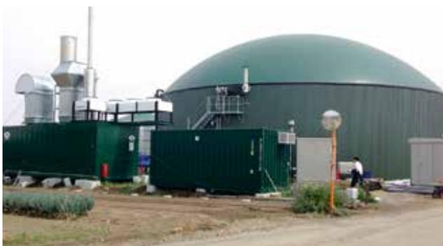
Biogasbehälter mit Doppelmembrandach in Japan
