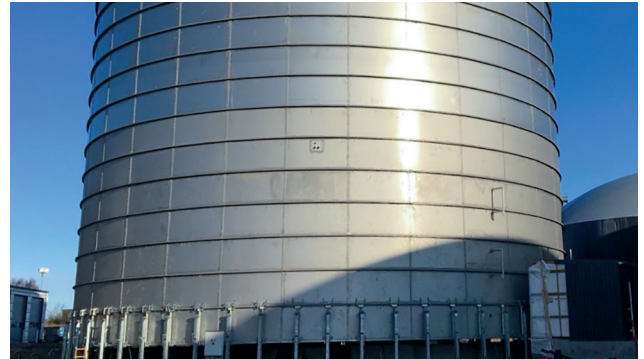
Montage durch Unterstockung Assembly by adding depth
