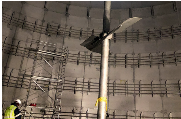
Montage Zentralrührwerk Assembly of central stirring system
