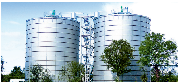
Zwei zentralgerührte Fermenter vor Isolierung und Verkleidung Two continuous stirred tanks before insulation and cladding
